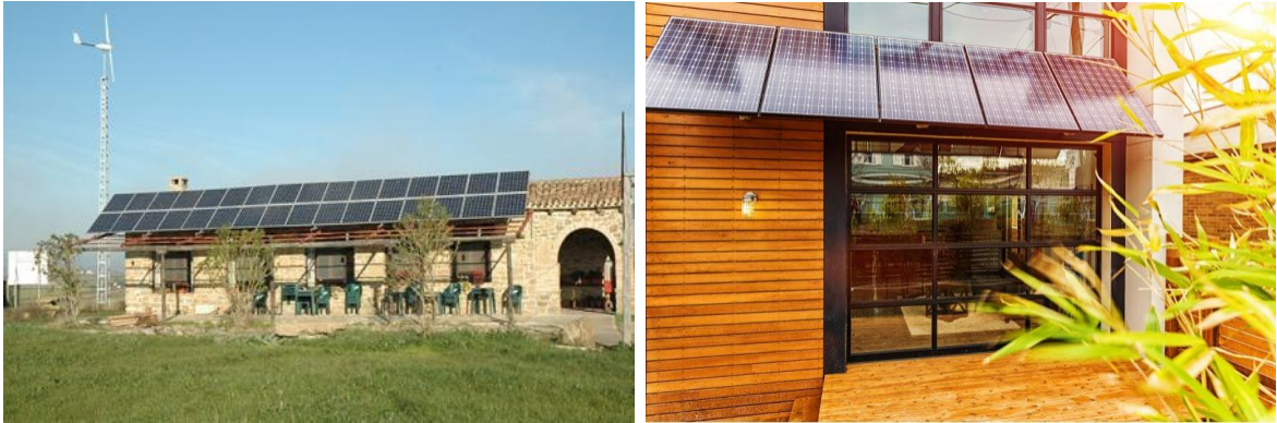
Figura 5: Instalación de colectores solares fotovoltaicos en un restaurante/cafetería
