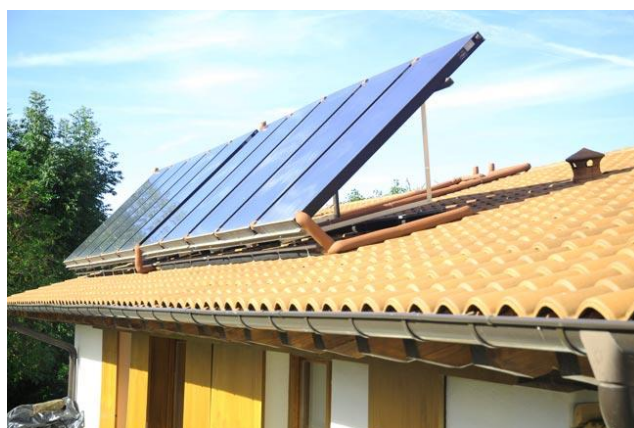
Figura 4: Instalación de colectores solares fotovoltaicos en un restaurante/cafetería
