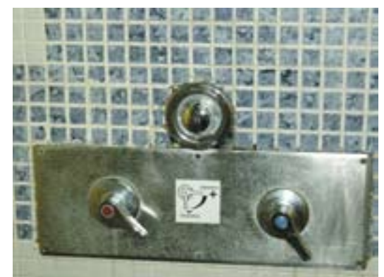
GRIFO TEMPORIZADO CON REGULACIÓN TEMPERATURA - STADIUM CASABLANCA
