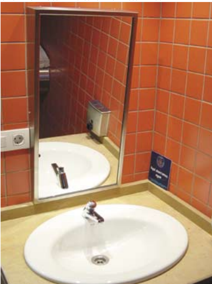
GRIFO TEMPORIZADO CON ADHESIVOS – CENTRO DE DOCUMENTACIÓN
