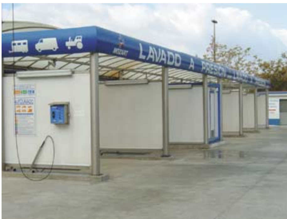
INSTALACIONES AUTO LAVADO MOZART
