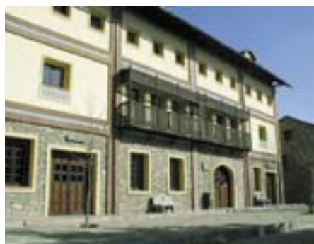
INSTALACIONES MORILLO DE TOU
