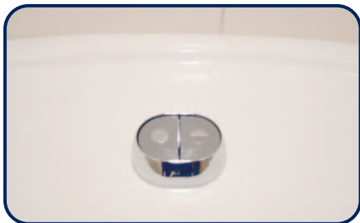
Pulsador de doble descarga en WC. ▲
