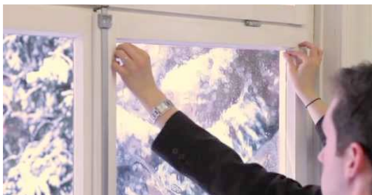
Foto. Vidrio de ventana en el que se está colocando el thermo cover
