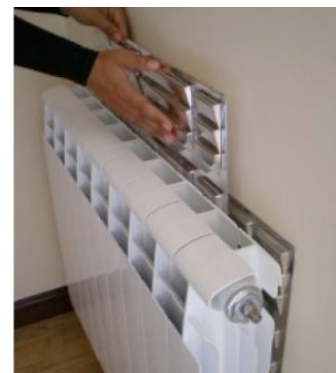
Figura 14. Reflector en radiador
